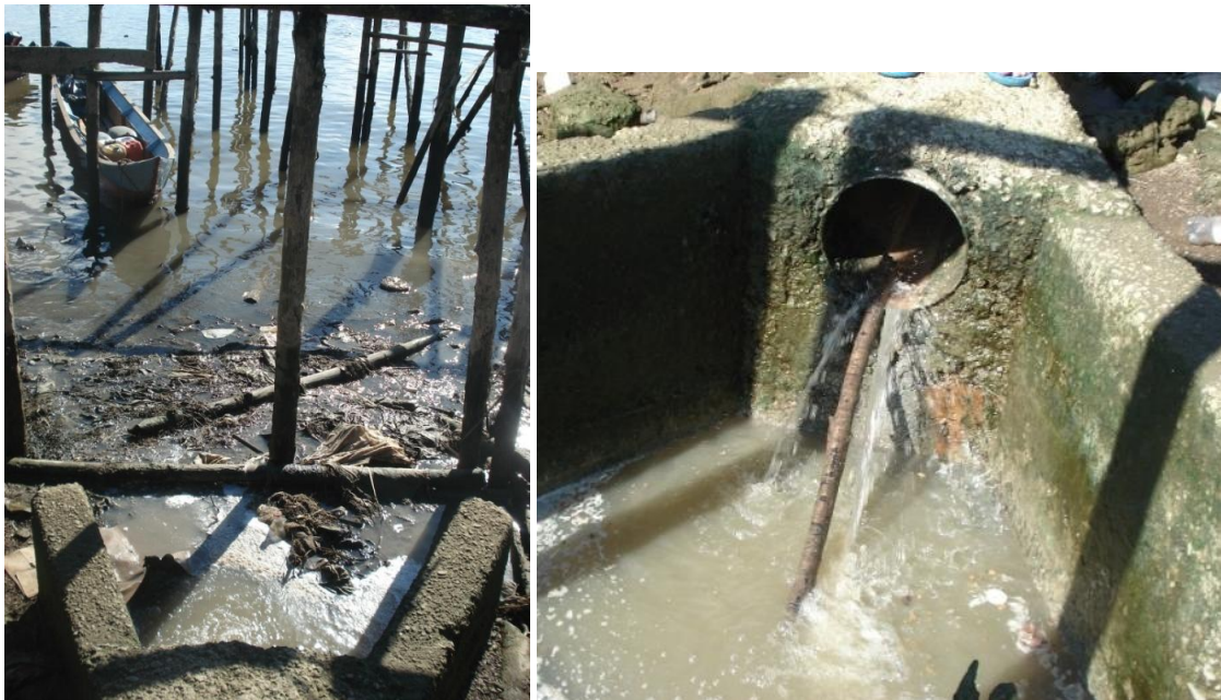
Figura 5.1-5. Disposición inadecuada de aguas residuales domésticas en el municipio de Guapi - Cauca
